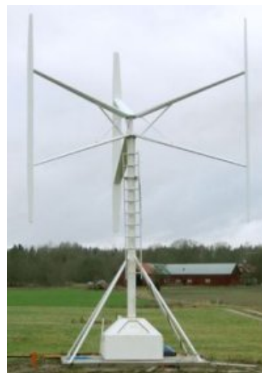
Figur 4 12kW prototyp designat av Vertical Wind.
