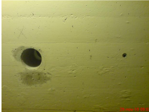
Bild 5 visar hål efter att borrkärna har tagits ur och en expanderskruv i väggen.
