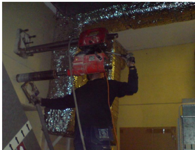
Bild 4 visar en upphängd bormaskin med 110 mm borr.
