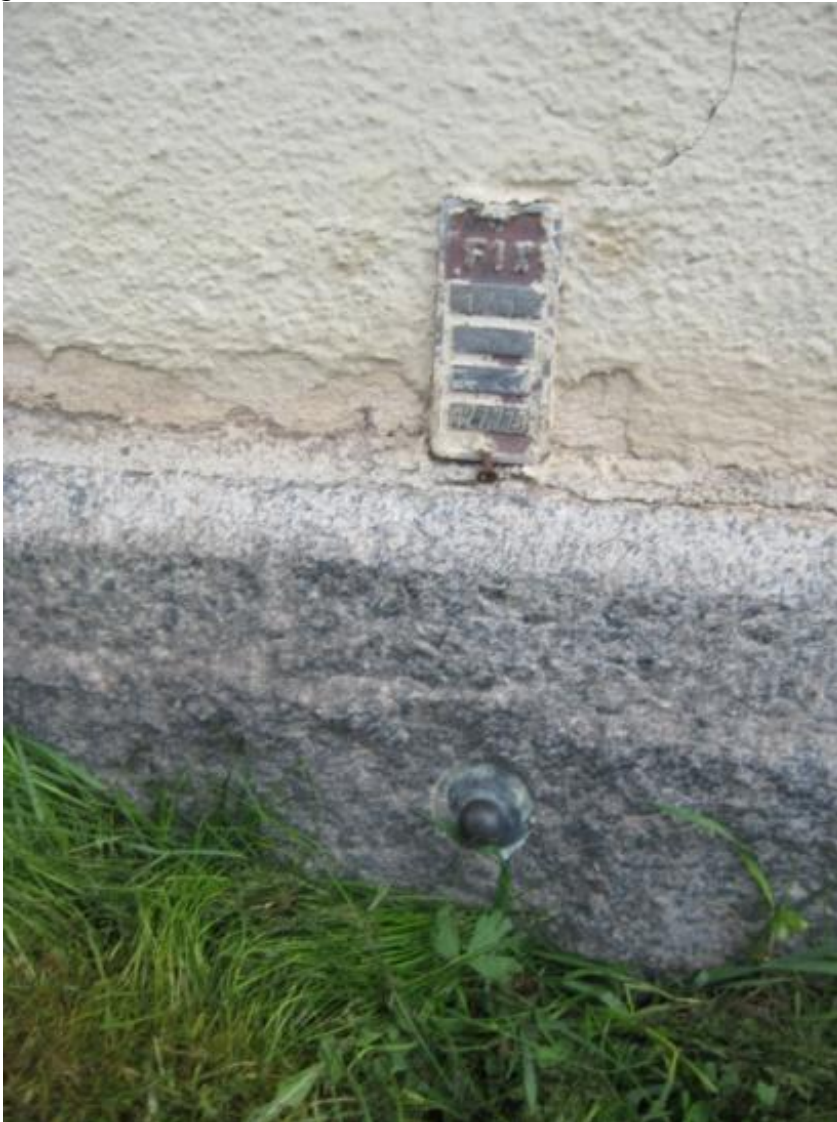
Figur 1: Höjdfix i närbild med ID-bricka. Höjdinformation kan skymtas på ID-brickans nedersta rad
