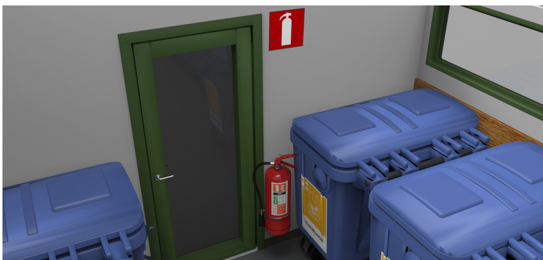
Brandsläckare direkt innanför dörren.
