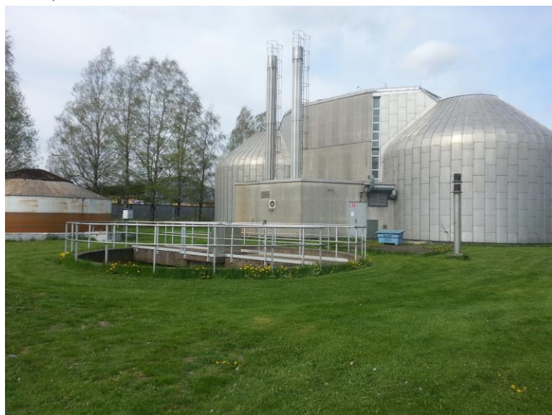
Figur 4. Visar den befintliga rötningsanläggningen till höger, förtjockare 1 i mitten och gasklockan till vänster, som är placerad på Krylbo ARV.
