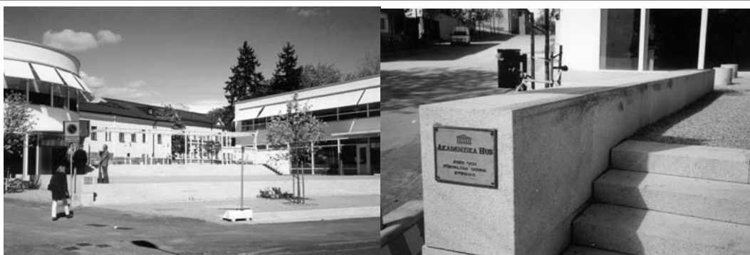
Bild 24 och 25. Campus Konradsberg mot Rålambsvägen vid Lärarhögskolan i Stockholm. Till vänster skejtbara trappor 7-5-3 innan de ”färdigställdes” med vit krossad marmor. Till höger kvardröjande skejtspår på socklar. Foto: Åsa Bäckström.
