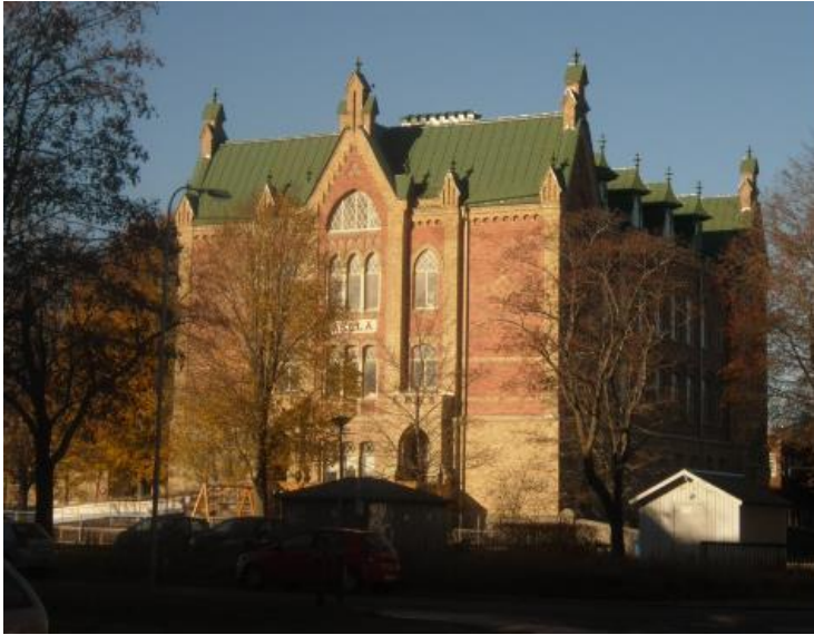
Figur 1 Slottets förskola. Bild tagen från södra sidan av byggnaden
